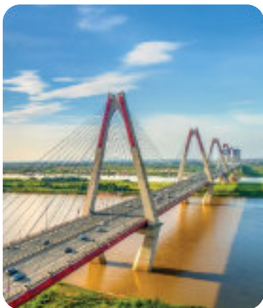
Cầu nhịp lớn, cầu dây văng, cầu dầm liên tục
